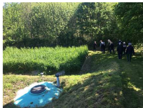
Le filtre horizontal et la cuve tampon
