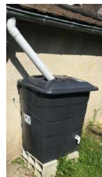
Le récupérateur d'eau
